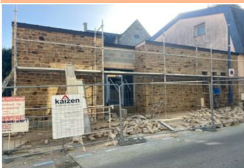
Côté rue Bodeloy (entrée)
